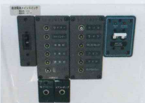
ブレーカーパネル
